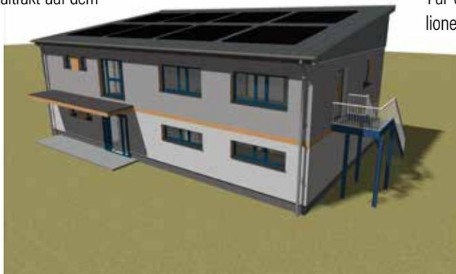
Für den neuen Sozialtrakt sind 1,3 Millionen Euro Baukosten im Haushalt veranschlagt. Eine Photovoltaikanlage auf dem Pultdach und eine Wärmepumpe bilden das Herzstück der Energie- und Wärmeversorgung. Das Gebäude erhält eine Wärmedämmfassade und Fußbodenheizung. Mit dem Bau des Sozialtraktes werden die Bedingungen für die Mitarbeiter
