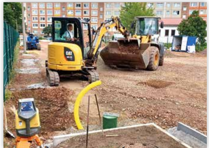
Mitarbeiter der Firma Keller-Tersch GmbH, einem auf Sportplatzbau spezialisierten Tiefbauunternehmen aus Schönebeck, arbeiten an der zukünftigen Laufstrecke.
