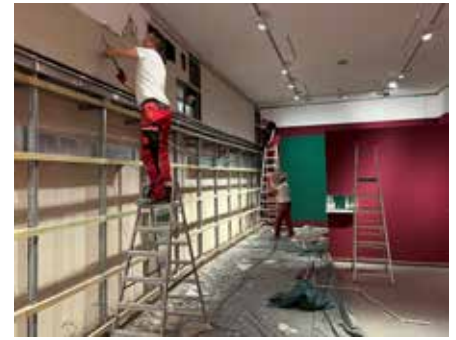
Arbeiter der Trockenbaufirma Bahs & Klein erneuern derzeit die Wände der Ausstellungsräume im Museum Lyonel Feininger, © Ute Huch.
