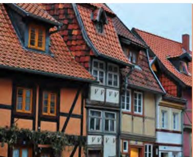
hoher Anteil an Fachwerkhäusern von außergewöhnlicher Qualität
