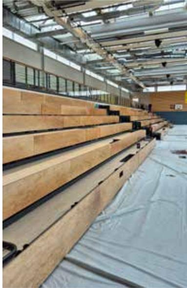
Die neuen Tribünen wurden in Bayern maßgefertigt, angeliefert und direkt vor Ort montiert. Mit einer Länge von jeweils rund zwölf Metern und fünf Sitzreihen pro Block bieten sie optimale Sicht auf das Spielfeld. Der Zugang erfolgt über die Empore und eine mittig angelegte Treppe, ergänzt durch seitliche Absturzsicherungen und Geländer.
