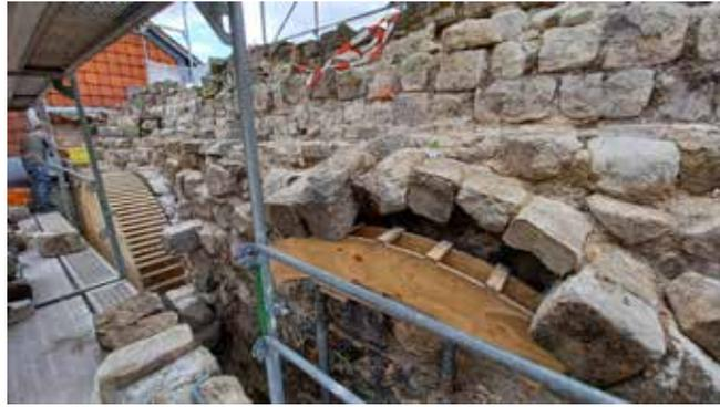
Bildunterschrift: Auf der Hofseite noch erkennbar sind der ehemalige Laufgang und die Holzbögen für den Wiederaufbau der fast zerstörten Steinbögen und Pforten
