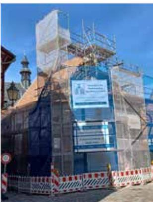
Seit Anfang Mai wird die Fassade des Fachwerkmuseums im Ständerbau, Wordgasse 3 mit dem Aufbau des Baugerüsts begonnen. Die Sanierung umfasst die gesamte Fassade, den Kalkputz, alle Sichtflächen der Fachwerkhölzer sowie den Natursteinsockel. Im Zuge dieser Arbeiten soll auch der Teil des Schornsteins, der über das Dach hinausragt, saniert werden. Schäden an der Dachfläche werden bei Bedarf
