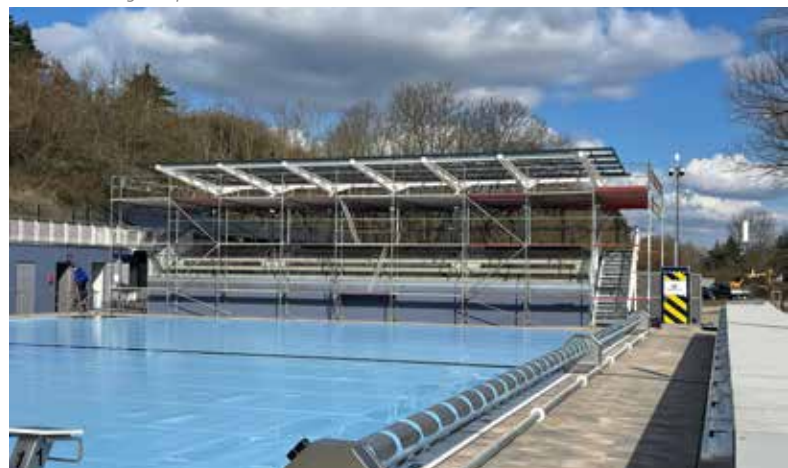
Für die Installation des Energiedaches ist die Tribüne eingerüstet.
