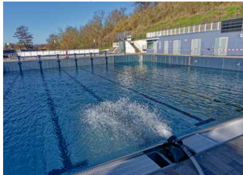
Mit der Befüllung des Sportbeckens wird der Saisonstart vorbereitet.
