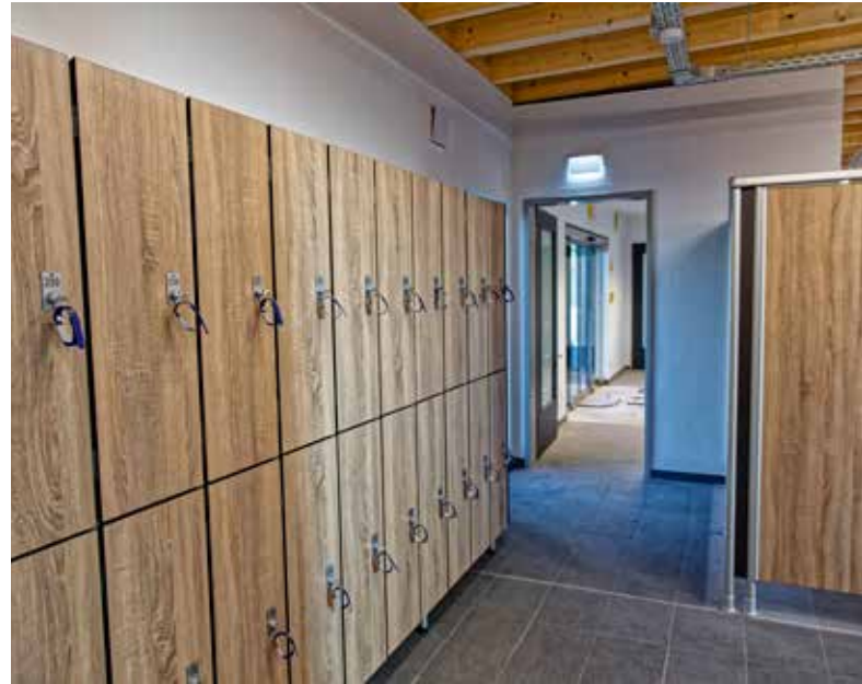
Die modernen Umkleidekabinen verfügen über 250 Schließfächer.
