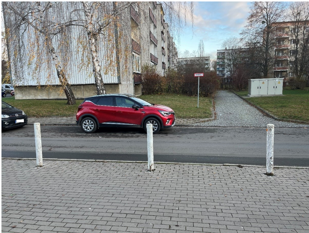
Abbildung 46: Fehlende Querungshilfen August-Bebel-Ring
