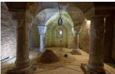
Bauarbeiten im Ottonenkeller auf dem Stiftsberg. Foto: Jürgen Meusel
