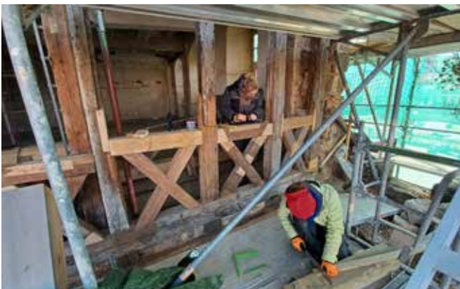
Jugendbauhütlerinnen erneuern historische Balkenkonstruktionen
