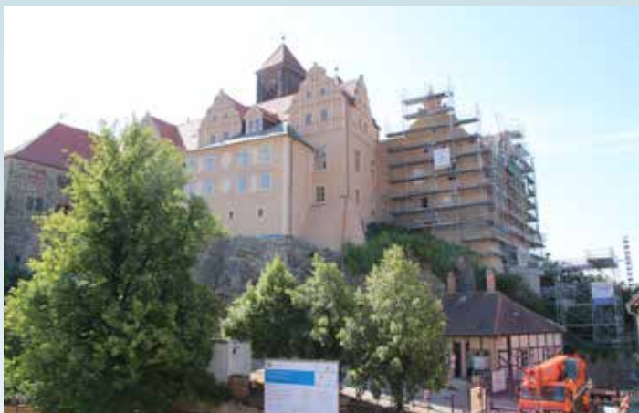
Rückbau am Stiftsberg
